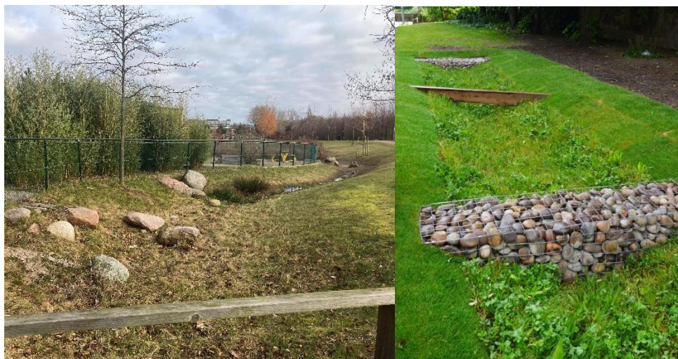
Figur 19. Exempel på utformning av svackdiken och dämmen. Foton: tv COWI, th Boverket (2019).
