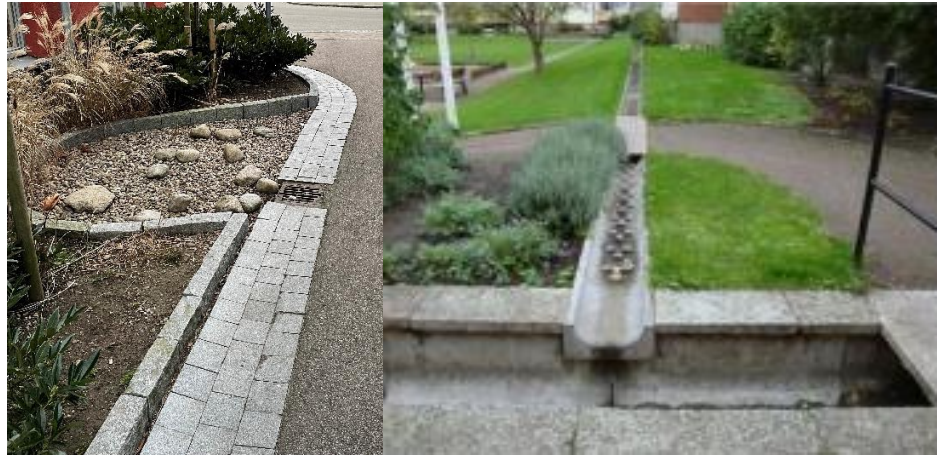
Figur 23. Exempel på utformning av dagvattenrännor. Foto: tv COWI, th Handbok för dagvattenhantering i Lerums kommun
