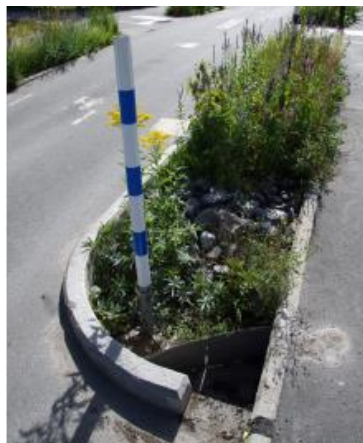
Figur 21. Exempel på hur ett avbrott i kantstenen kring en växtbädd kan användas för att skapa ett inlopp för dagvattnet. Bild av WRS hämtad från Stockholm Vatten och Avfall (SVOA).
