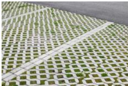
Figur 22. Exempel på gräsarmering, en form av genomsläpplig beläggning. Foto Sweco, hämtad från Handbok för dagvattenhantering i Lerums kommun .
